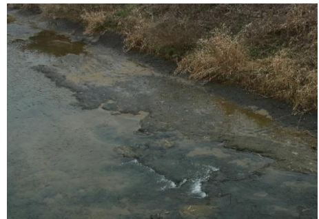
図16 <八女>弱溶結溶結凝灰岩の侵食された河床が見られる 内田川の川底 胡麻草
