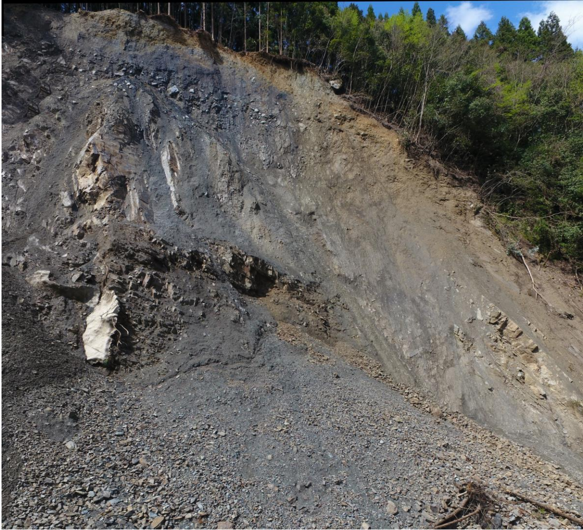
図6 崩壊現場の遠景写真
