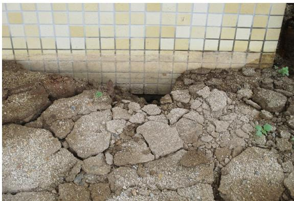
図27 地震による液状化(熊本県博物館ネットワークセンターにて)
