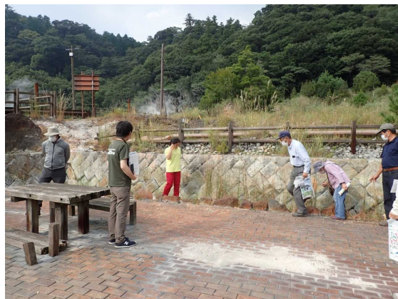
図19 公園のタイルや岩、釘などが噴気の影響で変質・変色している。
