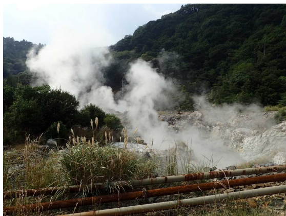
図18 硫黄谷噴気地帯では、写真手前のパイプで噴気や熱水を離れた場所へ送っている。
