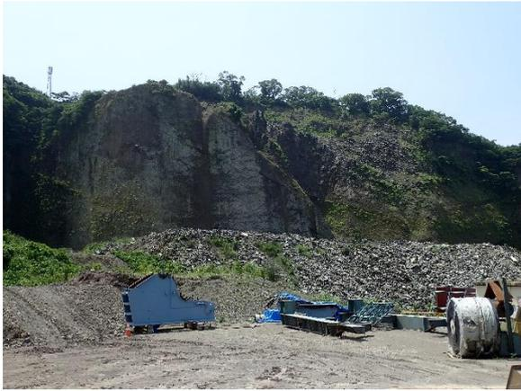
図4 採石場の状況。露頭下部は凝灰角礫岩、上部は節理が発達した安山岩。
