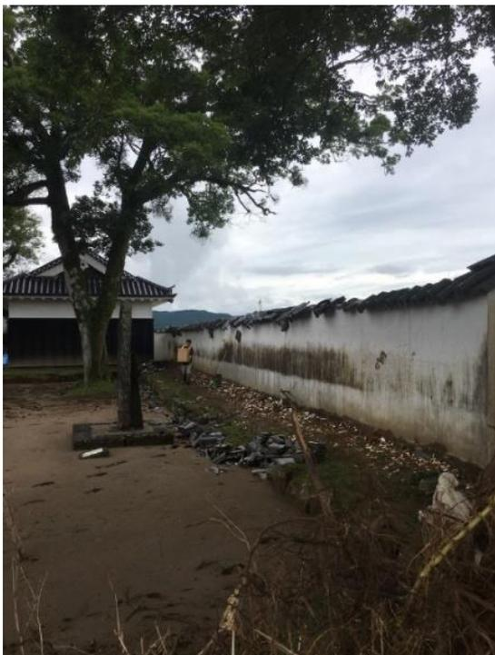
図1 前原勘次郎コレクションの植物標本を収蔵していた角櫓とそれに続く長塀（2020年7月15日撮影）。角櫓は球磨川（画面の右の塀の向こう側）と胸川（画面の角櫓の奥側）の合流地点に位置し、周辺には泥が厚く積もり、長塀の瓦が落下していた。
