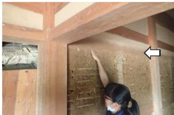
図4 角櫓内部の浸水被害の様子（2020年7月14日撮影）。床から約180cmの高さまで濡れて色が変わり（人物が指差すあたり）、浸水した部分の壁は塗り土が剥がれ落ちていた。
