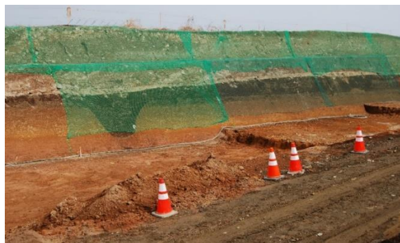
写真16 四方寄の道路工事現場
