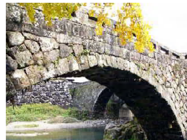
美里町 二俣橋
